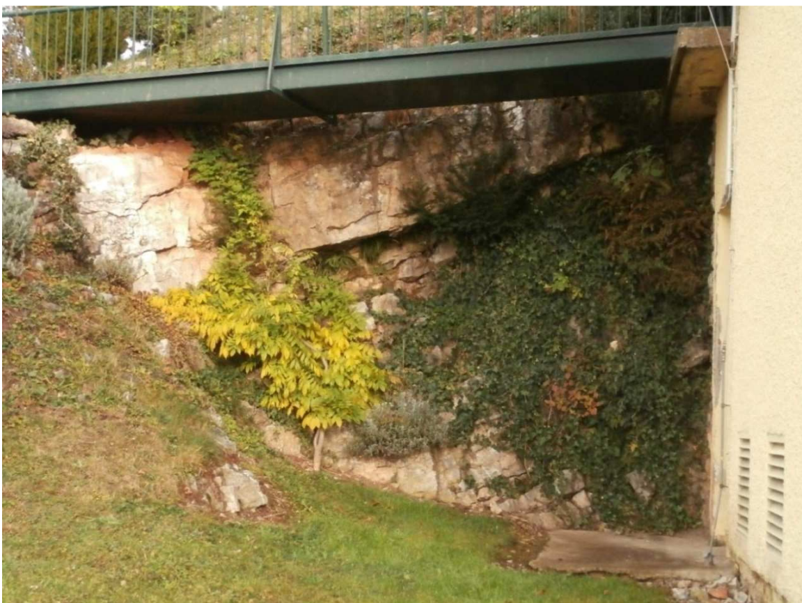
Die grüne Metallbrücke an der Nordwand des Gasthauses am Fürstenstand. Darunter ein Aufschluss in Kalksteinen der Plabutsch-Formation, in denen man vereinzelt Fossilien sehen kann. Der starke Bewuchs ist dabei etwas hinderlich. Bereich 1, 30.10.2015.
