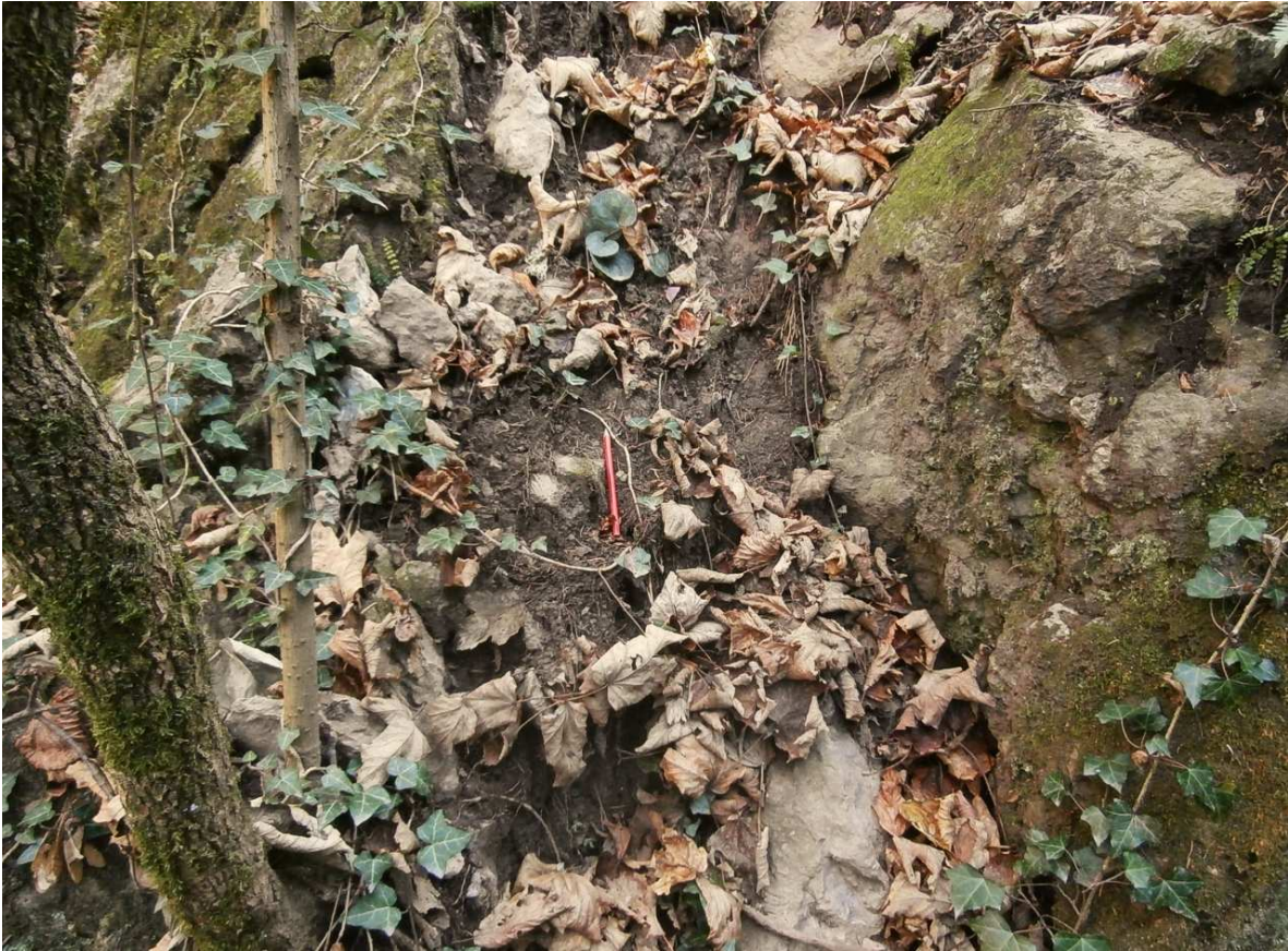
Die weiche, verwitterte und teilweise erdige Zwischenschicht zwischen dem festen Kalkstein, fast im obersten Teil der „Kanzel“ beim Punkt 59 wie vorgefunden. Links vom roten, ca. 12 cm langen Stift steckt ein Teil eines Vaccinites im weichen Material. 13.11.2022.
